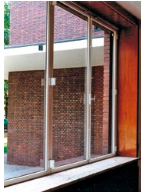
Abb. 12. Fensteranlage nach der Restaurierung, Haus Esters
