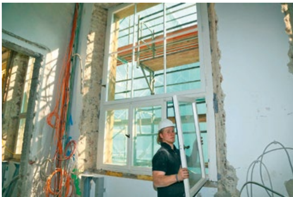
Abb. 2. Einbau der sanierten Alt-Fenster im Kaiser Wilhelm Museum.
