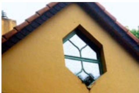
Abb. 27. Zinkfensterbank im Künstlerhaus nach der Restaurierung
