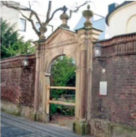
Abb. 18. Toranlage Mennonitenkirche vor der Restaurierung
