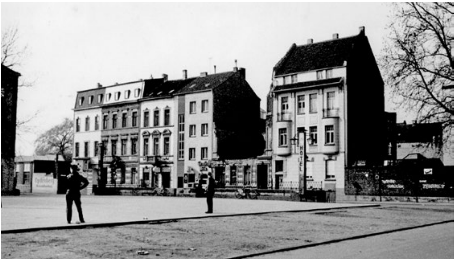
Abb. 7. Aus der Bauakte von Johannes Althoff 1960, Bauvorhaben Jägerstraße 71. Im Zentrum der Aufnahme ist die lückenhafte Bauzeile der Jägerstraße gegenüber dem Blumenplatz zu sehen. Von links nach rechts, noch angeschnitten, der Websaal der Paramenten-Weberei Dutzenberg, daran anschließend die Kohlenhandlung Opdenberg. Das Grundstück wurde, abgesehen von einigen Schuppen und dem kleinen Büro, nie bebaut. Es folgen drei gründerzeitliche Häuser, die den Krieg überstanden haben. In dem rechten befindet sich die Drogerie Beckers, ursprünglich eine Farbenhandlung und daneben, in dem an Stelle eines ausgebombten gründerzeitlichen Wohnhauses neu errichteten Wohnhaus, die Gaststätte Jäger-Klause. In der Ruine des Hauses Jägerstraße 71 wohnten bis zum Angriff neben Anderen auch die Opdenbergs. Durch den linken Eingang gelangt man über den Hof in die Schreinerei Althoff noch hinter dem Flügel, der den Krieg auch überstanden hatte. Dass daran anschließende Wohnhaus stammt aus der Zeit kurz vor dem Ersten Weltkrieg. Die schlichte Jugendstilfassade, die den Krieg überstanden hatte, fiel dem Modernisierungswahn zum Opfer und ist heute nicht mehr wiederzuerkennen. Daran schließt die Mauer eines weiteren Kohlenplatzes an, auf dem ebenfalls, abgesehen von ein paar Schuppen und Garagen, bis heute keine weiteren Gebäude errichtet wurden. Noch heute, wenn auch sehr stark verblasst, ist an der Mauer zu lesen: WENN CHRISTLICH – DANN ZENTRUM. Auf der niedrigen Abschlussmauer des Platzes gegenüber den Treppen, die zu den Bunkereingängen hinabführen – sie ist der einzig wirklich sichtbare Teil der unterirdischen Anlage und aufwendig aus Basalt errichtet –, befindet sich noch das rautenförmige schmiedeeiserne Gitter aus der Entstehungszeit. Die Markierung mit phosphoreszierender Farbe aus der Zeit der Verdunklung ist als heller Streifen zu sehen. An die beiden hohen Lüftungskästen aus Metall für Frischluft und Abluft sind Laternen montiert und auf dem rechten steht der Hinweis zu dem Bunker-Hotel. In der unbefestigten Fläche im Vordergrund ist zwischen der plattierten Platzfläche und der Fahrbahnkante der Kornstraße rechts noch die Außenkante des eigentlichen Bunkers zu erahnen. Diese unbeabsichtigt mit aufgenommenen Fußballspieler haben das „Tor“ wohl, wie üblich, mit zwei kleinen Steinen markiert.
