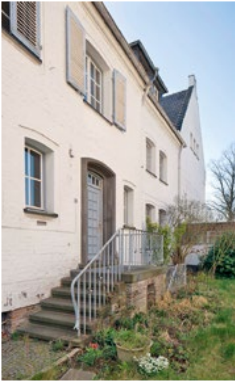
Abb. 4. Eingang des Direktorenhauses (mit Briefkasten)
