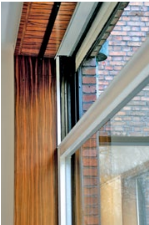
Abb. 14. Hebe- und Senkfenster Haus Lange, halb geöffnet
