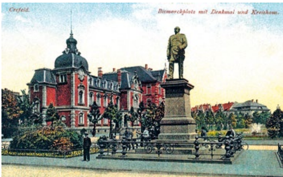
Abb. 8. Bismarckdenkmal auf dem Bismarckplatz, historische Aufnahme
