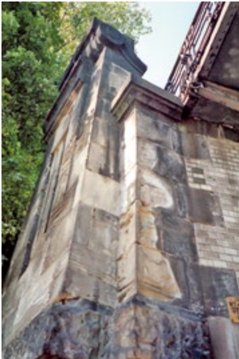
Abb. 10. Brückenpfeiler, Eisenbahnbrücke am Voltaplatz
