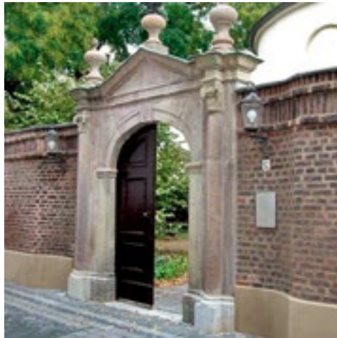
Abb. 19. Toranlage Mennonitenkirche nach der Restaurierung
