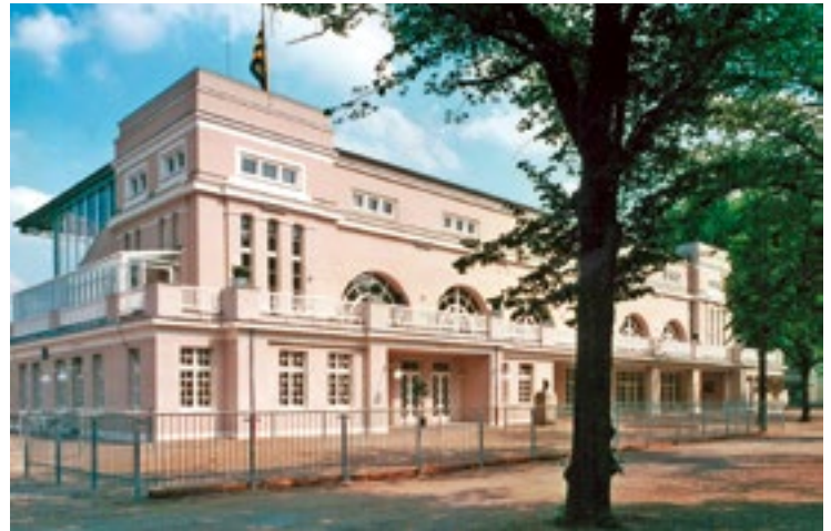
Abb. 4. 1. Tribüne nach der Restaurierung
