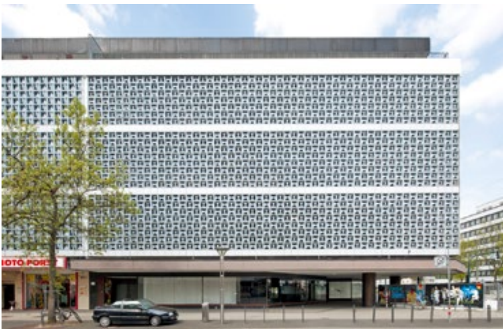
Abb. 1. Krefeld, Rheinstraße, Horten-Fassade mit den Horten-Kacheln und den für das links anschließende Haus der Tivoli-Brauerei modifizierten Kacheln
