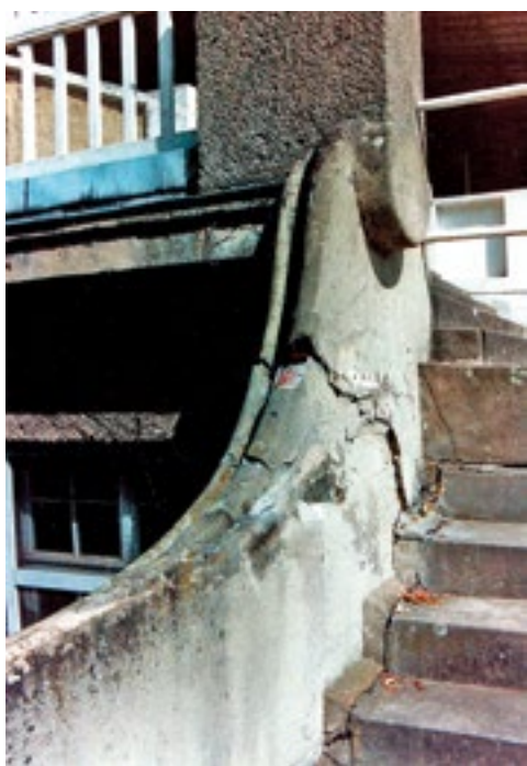
Abb. 7. Treppenaufgang zur Tribüne vor der Restaurierung
