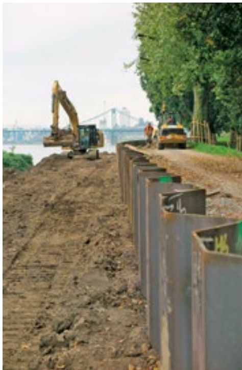
Abb. 5. Sanierung des Rheindeichs in Krefeld-Uerdingen.
