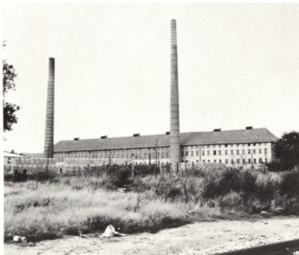
Abb. 5: Ziegelwerk in Bracht, in dem Reu ver- und Tegelentone zu Großformat-Gittersteinen verarbeitet werden.
