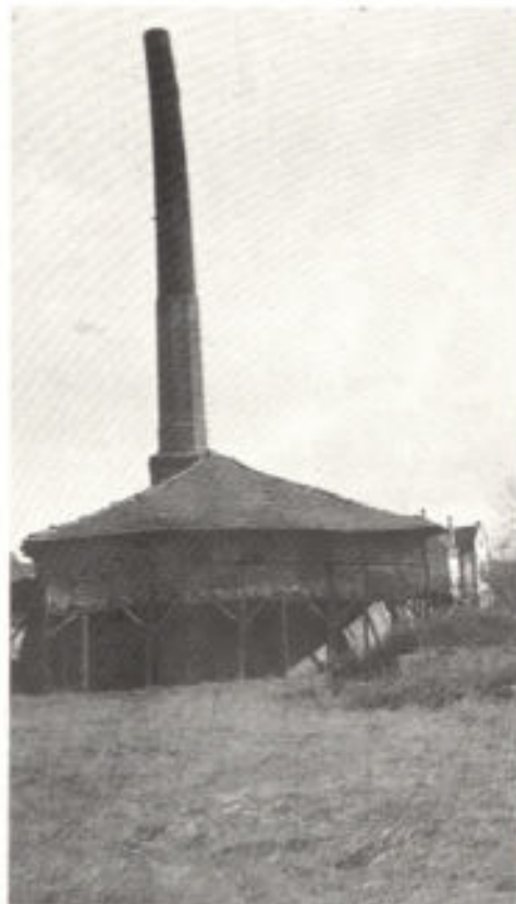
Abb. 6: (Farbdia) Stillgelegter Ringofen in Bedburg, in dem Lehmziegel gebrannt wurden.
