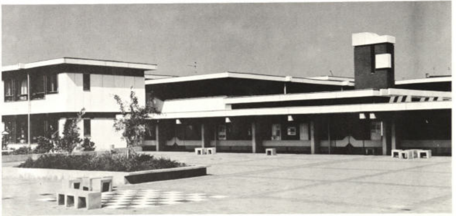
Hauptschule St. Tönis, Blick vom Pausenhof
