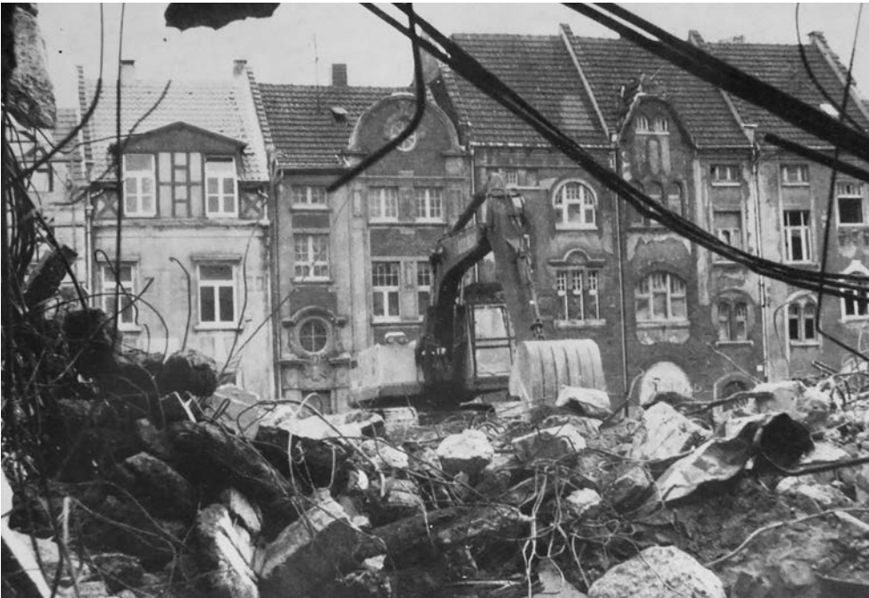
Abb. 8: Abbruch der Hochgarage. Im Hintergrund die Mühlenstraße
