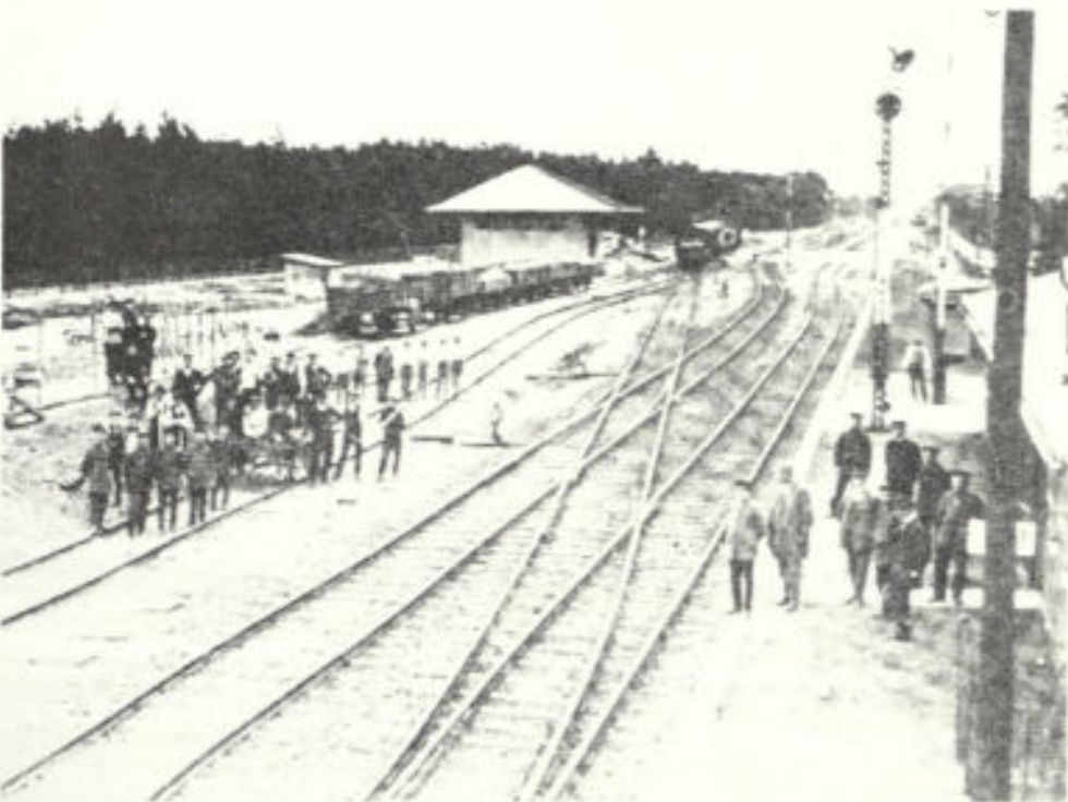
Abb. 5. Im Jahre 1914 wird der zweigleisige Ausbau der Strecke und der Bau des Bahnhofsgebäudes „Forsthaus“ vollendet.
