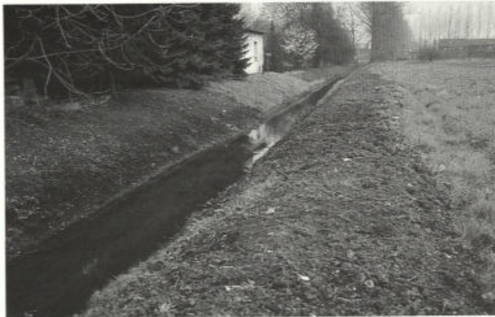
Abb. 2. Flöthbach: Sohlenräumung; Aufnahme: April 1986
