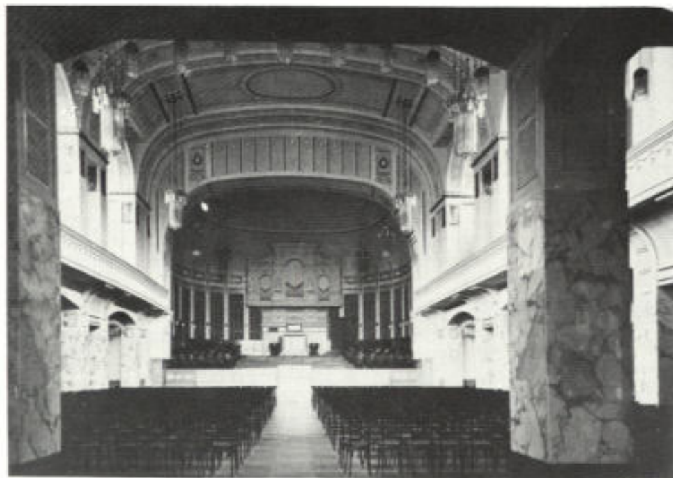
Abb. 6. Stadthalle; großer Saal nach dem Umbau 1917
