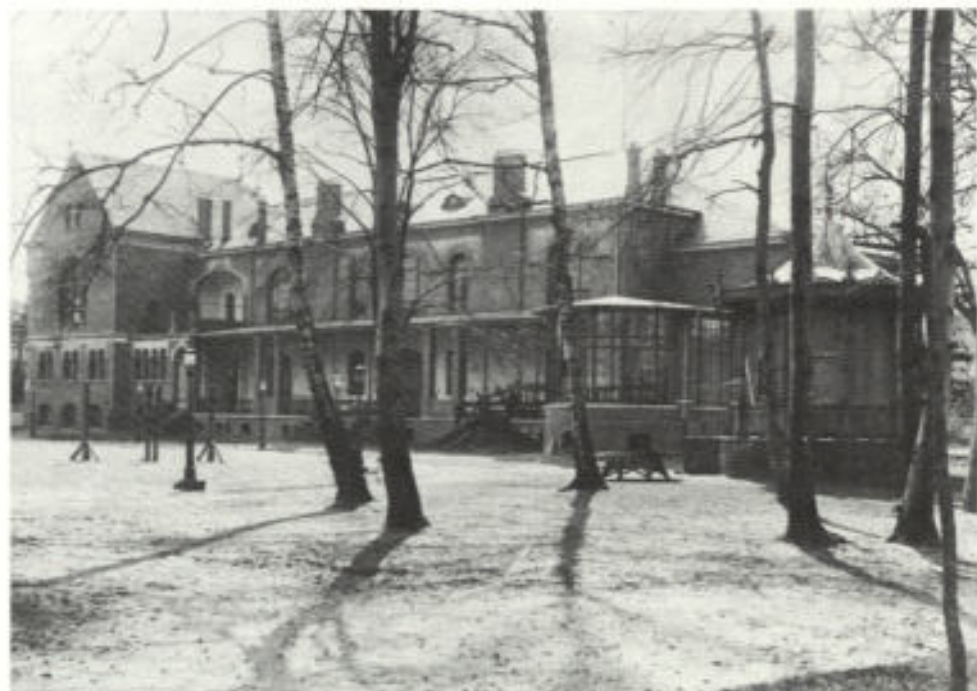
Abb. 12. Haus Blumental; Ansicht von Osten; Blick auf den großen Saal
