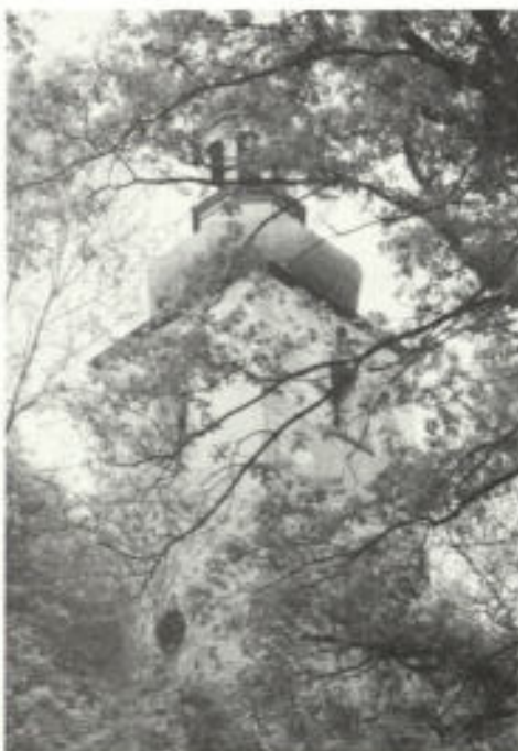
Abb. 1. Barockturm der Marienkirche (Zustand 1988)
