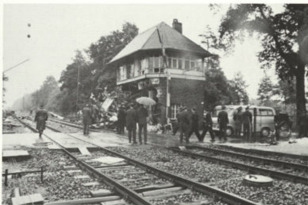
Abb. 1. Die Kreuzung Bellenweg/Bundesbahn nach dem Unfall; das zerstörte Stellwerkgebäude, davor die geöffnete Schranke (hochstehend, geknickter Schrankenbaum); ganz rechts das beschädigte Fahrrad des glücklicherweise dem Unfall entgangenen Kronzeugen des Geschehens
