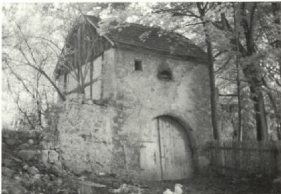
Abb. 2. Torhaus der Wehrkirchenringmauer mit Pechnase (Zustand 1988)
