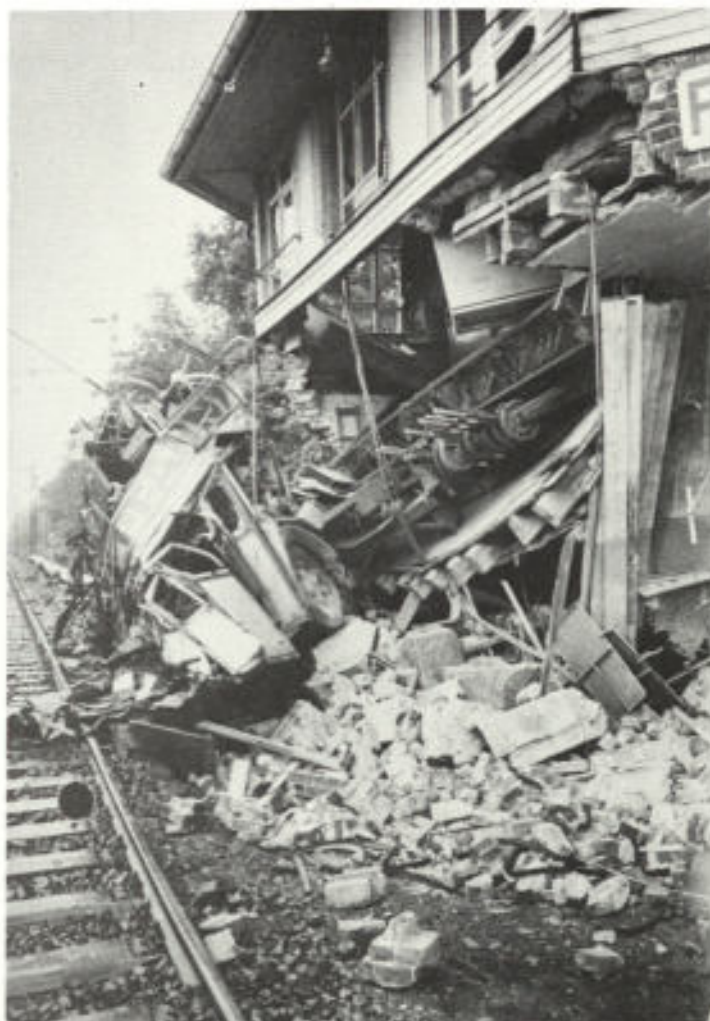
Abb. 3. Trümmer von Bus und Stellwerkhaus; der Schrankenwärter war mit in die Tiefe gestürzt und hatte schwere Verletzungen erlitten
