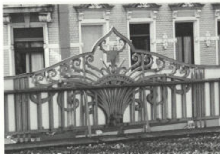
Abb. 28. Kölner Straße, Eisenbahnbrücke
