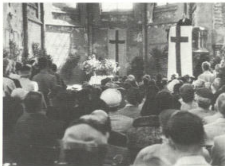
Abb. 10. Wiederaufbau; nachdem die Trümmer aus dem zerstörten Kirchenschiff weggeräumt waren, feierte die Friedenskirchen-Gemeinde – unter freiem Himmel und bei leeren Fensterhöhlen und Türöffnungen – einen Dank- und Fürbittgottesdienst für den Neuanfang; auf der Kanzel der Kirchenruine: Pfarrer Ulrich Lagemann (1955)
