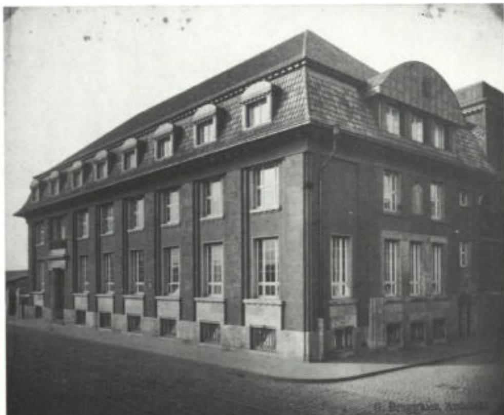
Abb. 11. Außenansicht des Verwaltungsgebäudes der städtischen G-E-W-Werke; Blick auf die Ecke Kanalstraße (heute Hansastraße)/Elisabethstraße kurz nach der Inbetriebnahme
