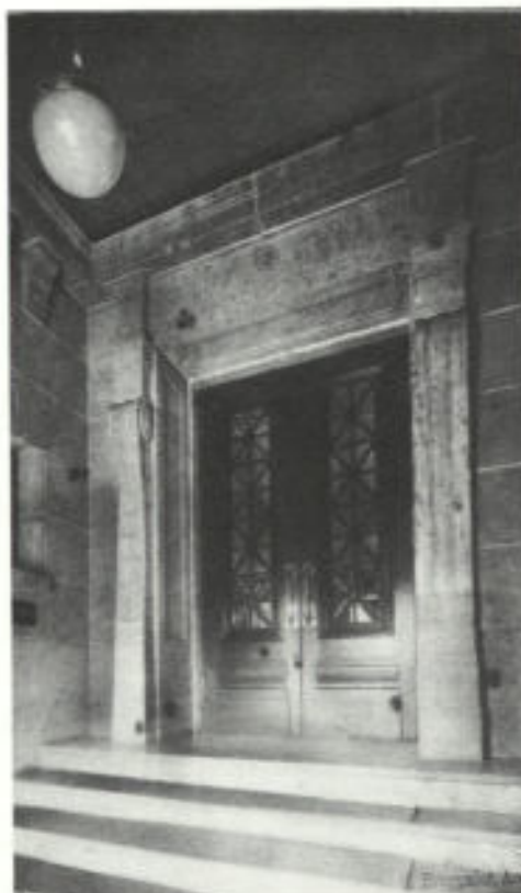
Abb. 12. Haupteingang des Verwaltungsgebäudes der städtischen G-E-W-Werke
