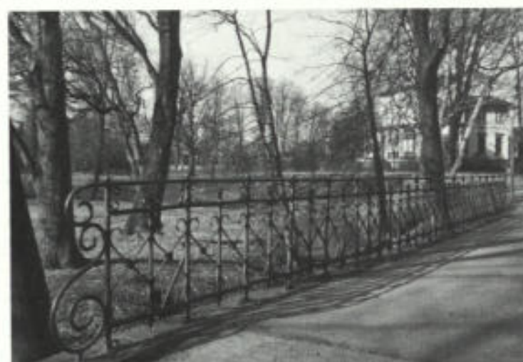
Abb. 30. Brücke im Sollbrüggenpark
