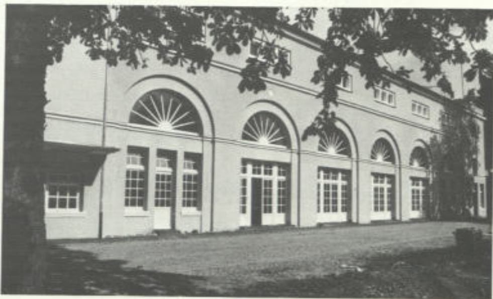
Abb. 3. Bribrichers Rennbahn-Gebäude erstrahlen in neuem Glanz
