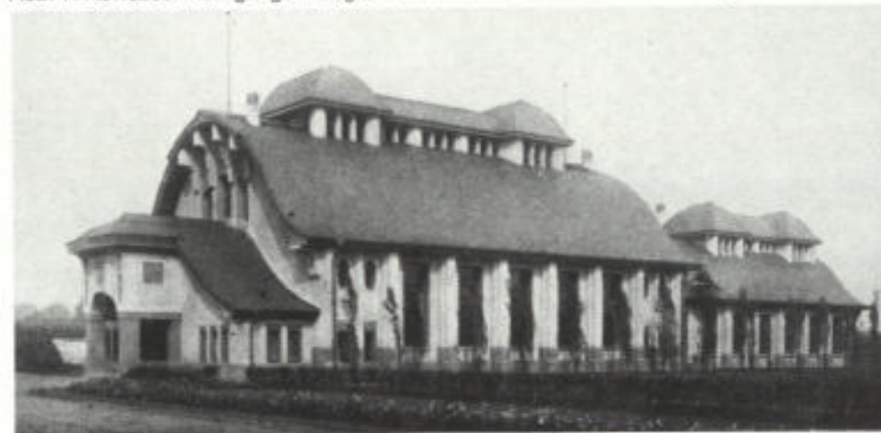
Abb. 7. Abwasser-Reinigungs-Anlage; Aufnahme kurz nach der Realisierung; Ostansicht
