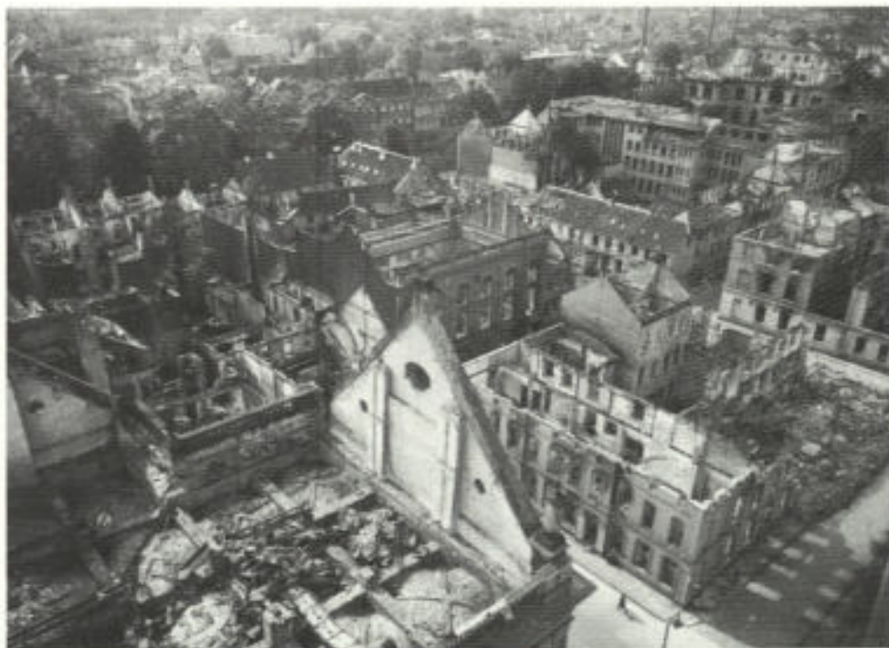
Abb. 3. Blick vom Turm der Dionysiuskirche über das in der Nacht vom 21. zum 22. Juni 1943 ausgebrannte Dach in nordwestliche Richtung; oben links ist der Westwall mit seinen Bäumen, in der Mitte der Saal der „Gesellschaft Erholung“ und oben rechts das zerstörte Rathaus, erkennbar am Portikus, zu sehen.
