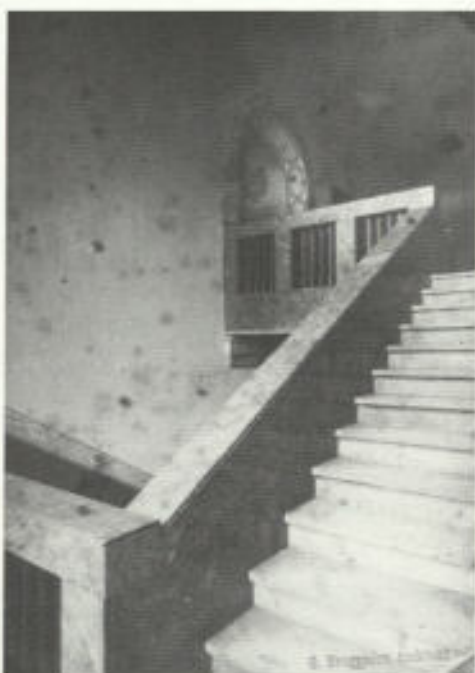
Abb. 15. Treppenhaus im Gebäude der städtischen G-E-W-Werke
