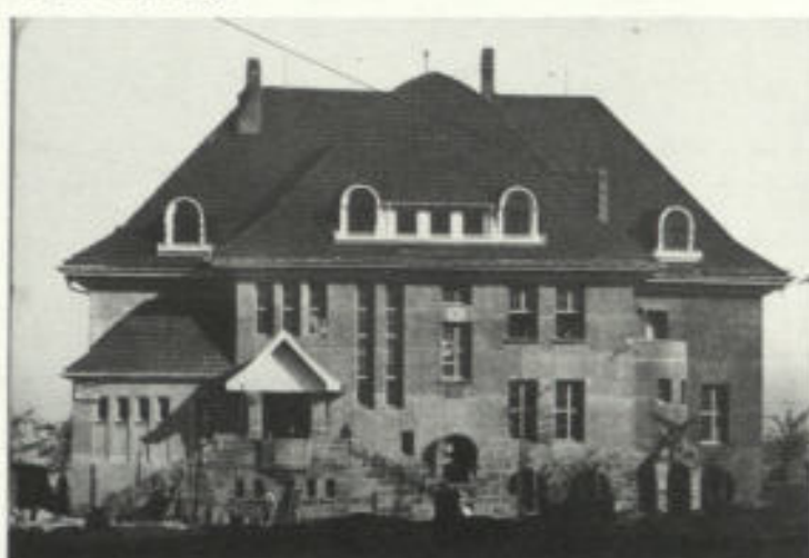
Abb. 5. Das Hafenrestaurant Rheingold; Westansicht; Ansicht kurz vor der Vollendung
