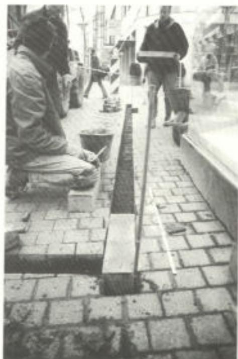
Abb. 14. Verlegung der in Beton eingebetteten Eisengußteile
