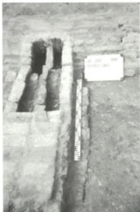
Abb. 9. Zweirinniger Backsteinzulauf in den Kanal von 1822
