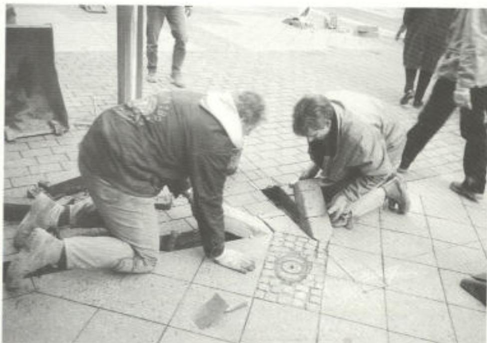
Abb. 13. Herausnahme der ausgeschnittenen Plattenstücke
