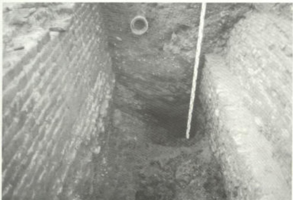
Abb. 8. Blick von Nordwesten auf die Stützmauer am Stadtgraben und den 1822 in den Stadtgraben eingesetzten Ziegelkanal
