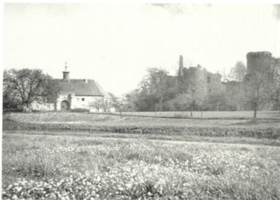
Abb. 7. Äußerer Graben, Zehntscheune und Burg; um 1929
