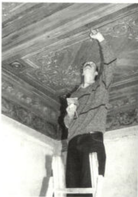
Abb. 1. Der Restaurator bei der Arbeit an der Decke in Haus Sollbrüggen
