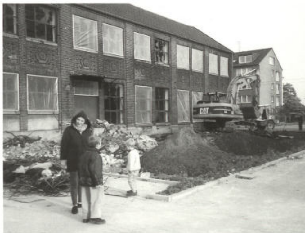
Abb. 2. Die Südseite des Gebäudes vor dem Umbau
