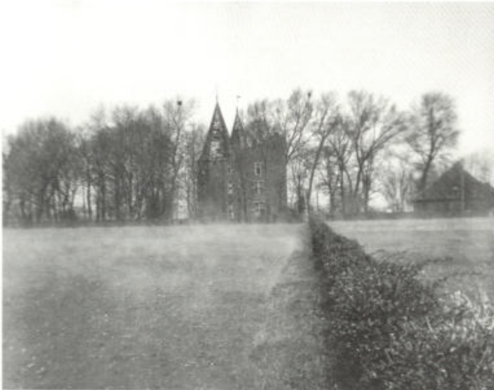
Abb. 12. Haus Dreven von Süden; Frühjahr 1954
