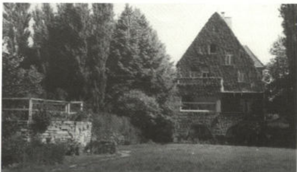
Abb. 10. Die Villa Vorsterstraße 41, ab 1946 Sitz der Hauptverwaltung der ÖDTV in Krefeld und der 1947 gegründeten Michael-Rott-Schule
