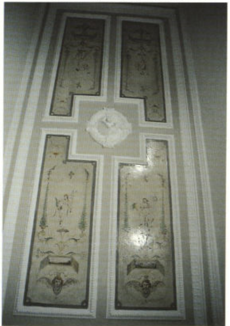
Abb. 5. Die restaurierte Decke im Flur des Hauses Westwall 164
