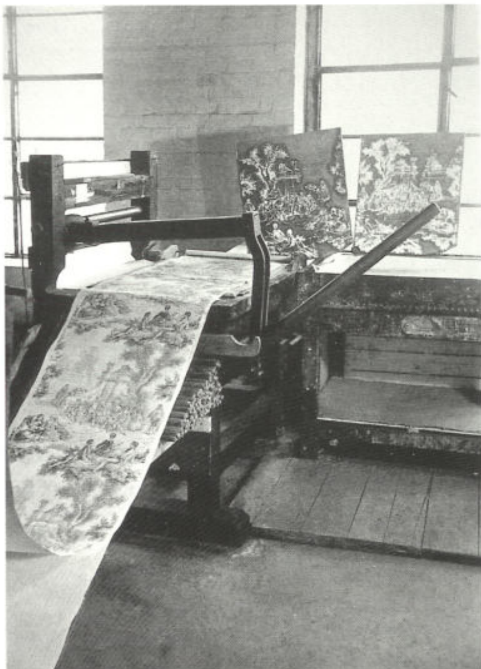
Abb. 1. Handdrucktisch mit Tapete und den dazu verwendeten zwei hölzernen Handdruckformen, auf denen die Stellen, die Farbe erhalten und abgeben sollen, erhöht sind. Für jede aufzudruckende Farbe ist eine besondere Druckplatte nötig. Mit Farbe bedeckt wird sie auf das ausgebreitete Papier an markierten Einsatzstellen gepreßt. Danach muß das Papier erst trocknen, bevor es erneut bedruckt werden kann.
