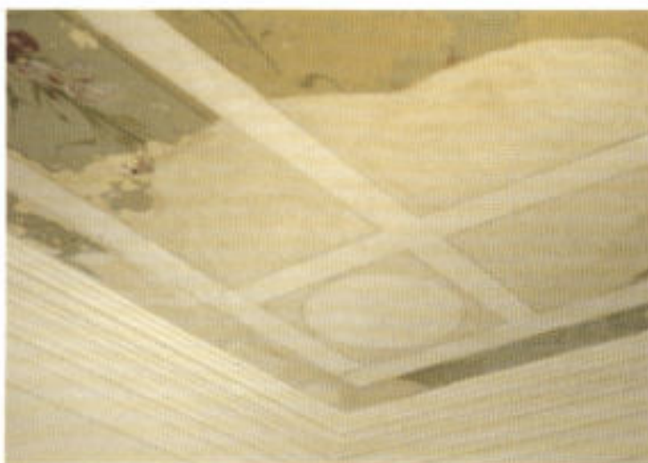
Abb. 8. Großes Zimmer, Haus Westwall 164: Deckenfeld vor der Restaurierung
