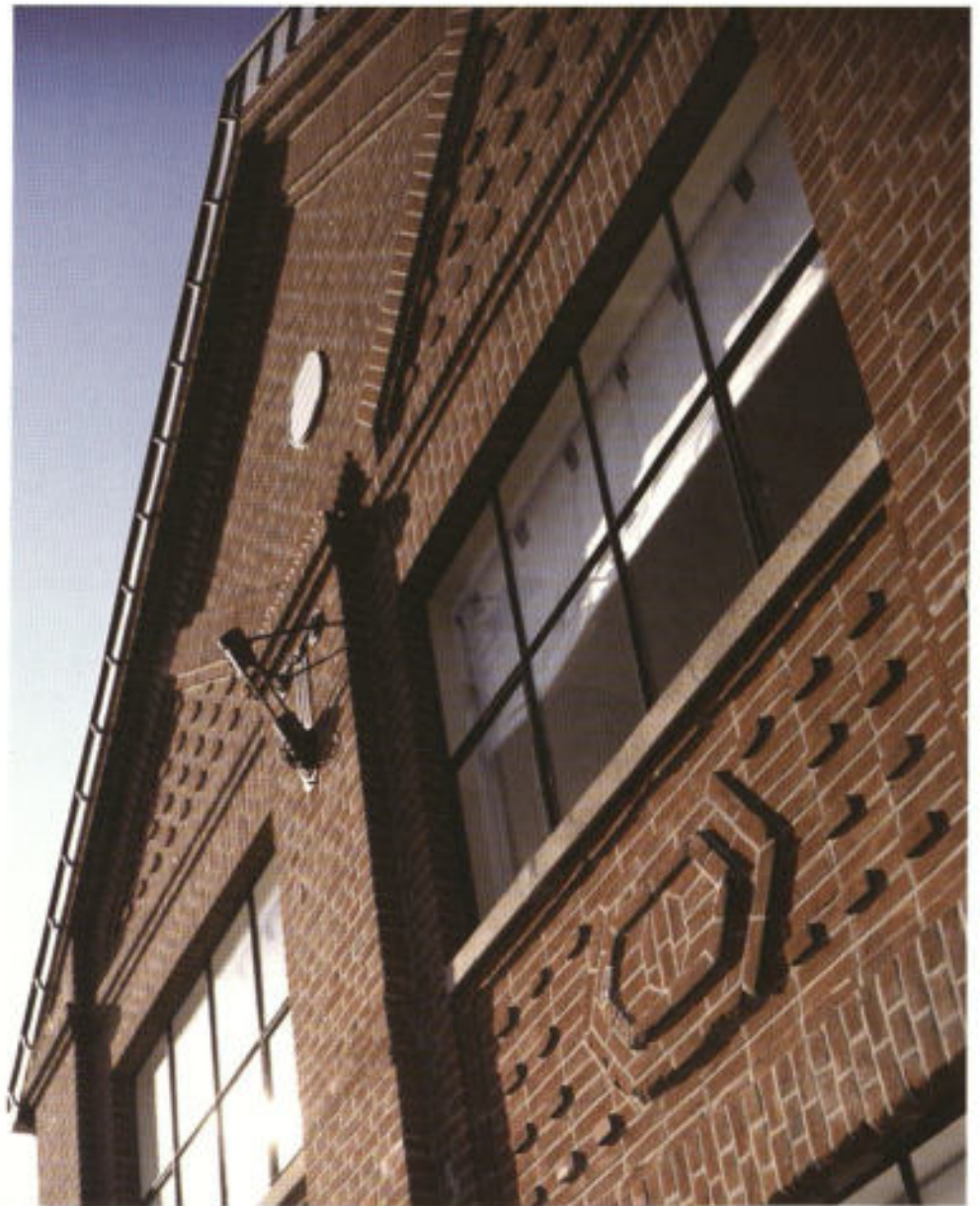
Abb. 1. Detail der Giebelseite zur Hülser Straße hin
