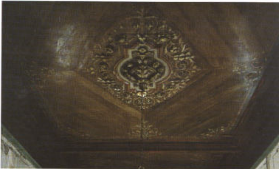
Abb. 3. Die Decke nach der Restaurierung
