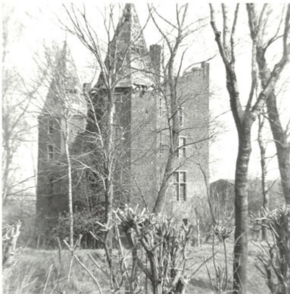
Abb. 4. Burgruine Haus Dreven (1955). Der Anbau rechts wurde 1923 von Johannes Frangen vorgenommen.
