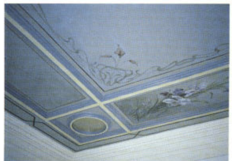
Abb. 9. Deckenfeld nach der Restaurierung
