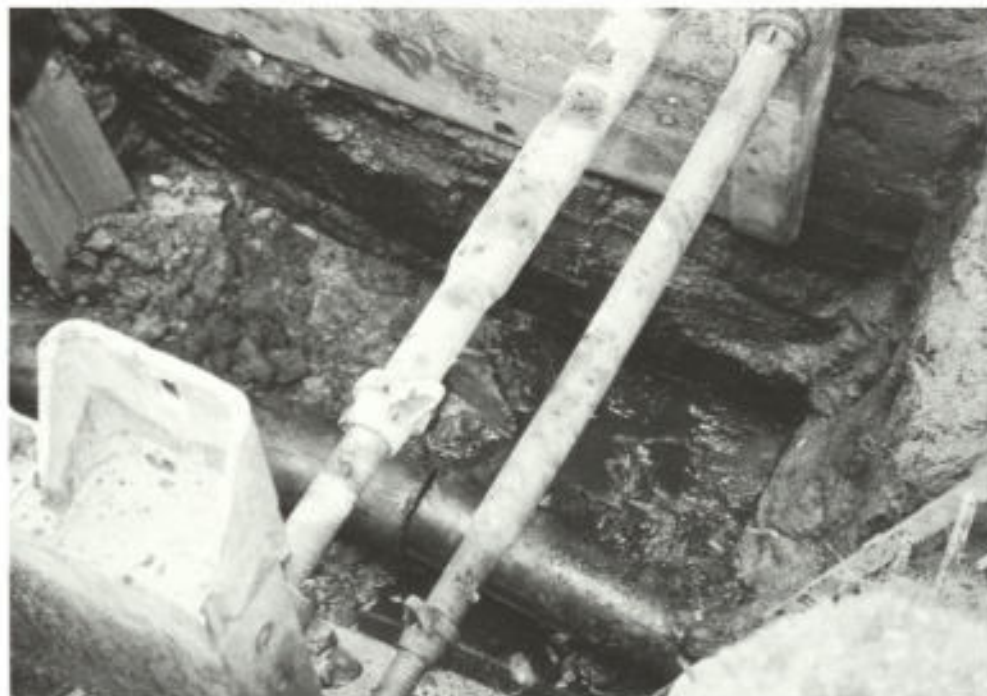
Abb. 4. Baggerarbeiten am nördlichen Ende der Fußgängerbrücke ermöglichten im Herbst 2001 noch einmal einen Blick auf den alten, 1 bis 2 m mächtigen schwarzen Schlamm in „Originallage“.
