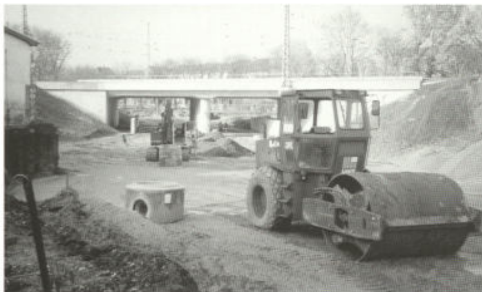
Abb. 3. Entlastung für die Innenstadt: die Tunnel-Baustelle am Deutschen Ring.
