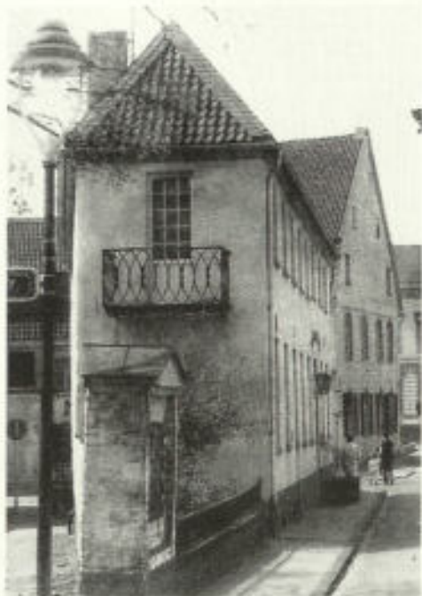
Abb. 15. Die Fußfall-Station Nr. 5 auf dem Grundstück der Wirtschaft „Zum Bügel-eisen“
