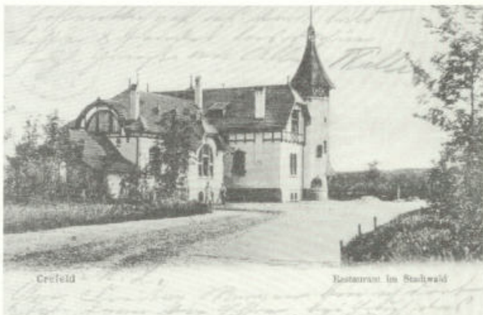
Abb. 2. Restaurant im Stadtwald, Südwestansicht; um 1903
