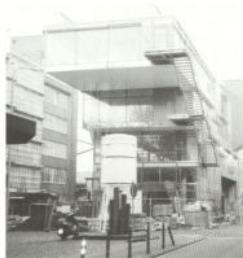
Abb. 7. Die Gerüste sind gefallen. Der „Behnisch-Bau“ wird als 170 Meter lange Glasplastik im Bild der Innenstadt sichtbar. Eröffnungstermin und Innenleben bleiben noch im Ungewissen.
