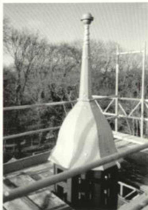
Abb. 18. Der Treppenturm während der Renovierungsarbeiten
