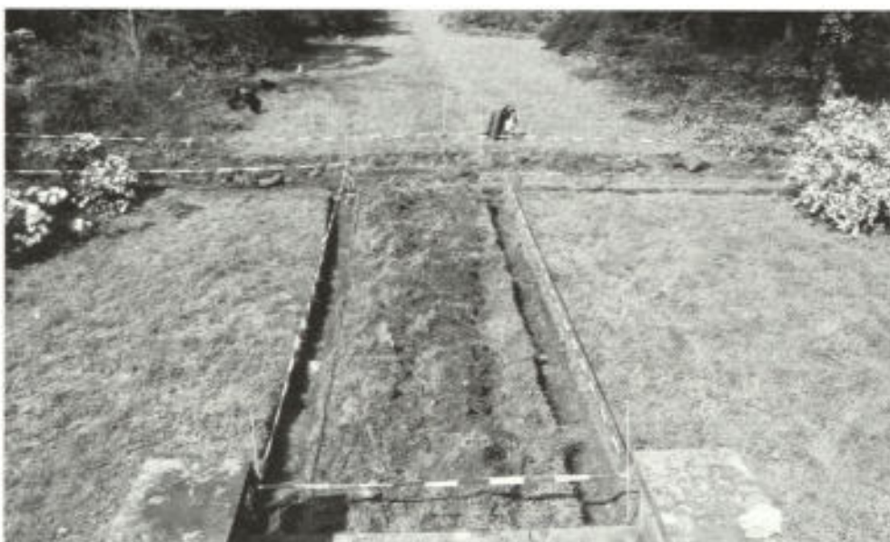
Abb. 10. Restaurierungsarbeiten in den 90er Jahren: Freilegen alter Wege im „Gehölzgarten“. Unterbau und Kantensteine sind größtenteils gut erhalten.
