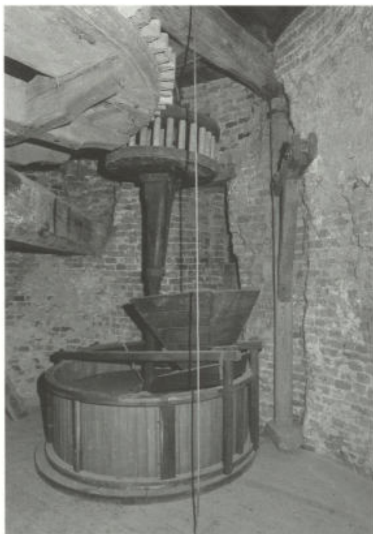
Abb. 3. Mahlwerk der Geismühle, Krefeld-Oppum; 1991
