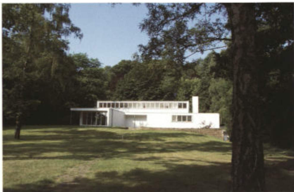
Abb. 3. Vorderansicht des Hauses
