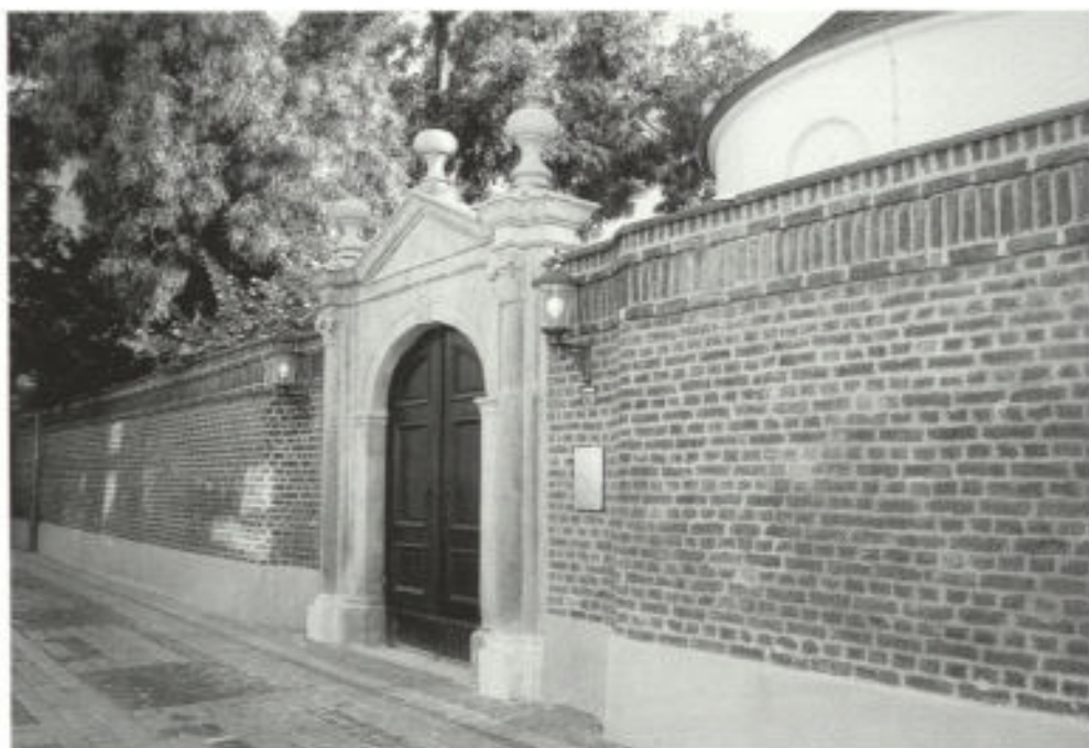
Abb. 5. Wieder standfest: Mit Hilfe von Spenden wurde das Tor zum Hof der Mennonitenkirche saniert, immerhin das älteste Bauwerk der Innenstadt.
