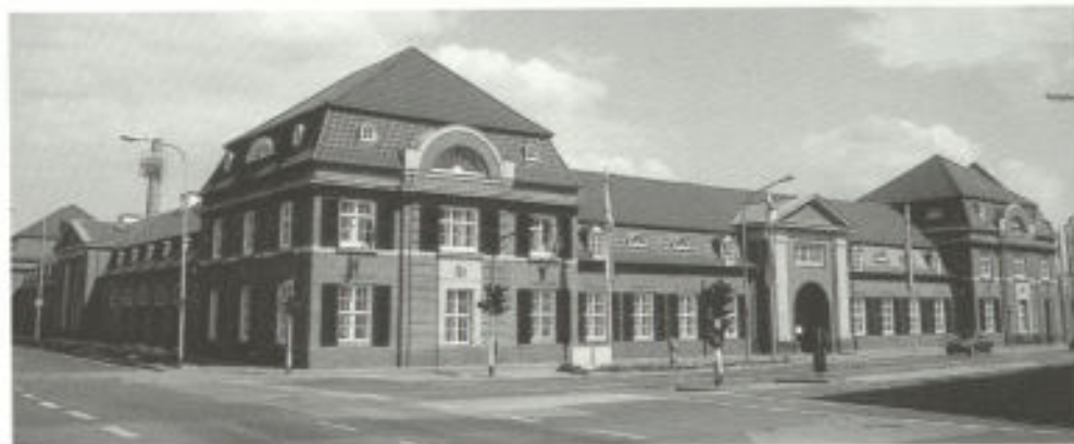
Abb. 3. Architekt Biebricher würde sich freuen: Der ehemalige Schirrhof der Stadt wurde von seinem neuen Besitzer stilgerecht renoviert.
