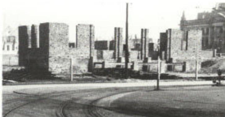
Abb. 5. Garnisonstheater, stillgelegte Baustelle
