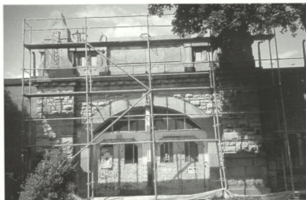
Abb. 7. Renovierungsarbeiten an der Fassade
