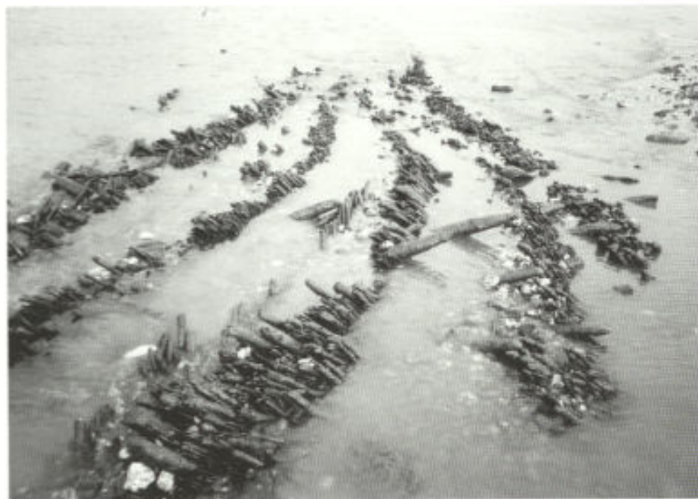
Abb. 4. Holzreste ehemaliger Buhnen von 1820 am Rhein bei Extrem-Niedrigwasser, Strom-km 828,7, bei einem Wasserstand von 1,3 bis 1,1 m, am 25. September 2003
