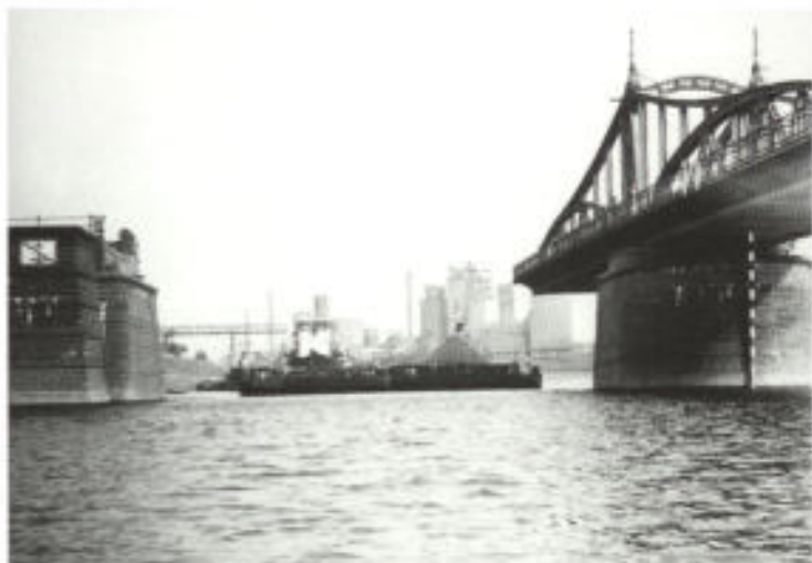
Abb. 12. Brücke in geöffnetem Zustand; Drehung um 90°
