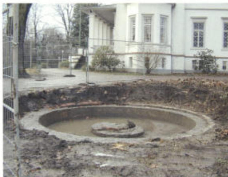
Abb. 14. Bei garten-archäologischen Grabungen vor der Gebäudefassade wiedergefundenes Brunnenbecken; Januar 2003
