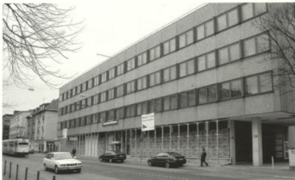
Die beiden Obergeschosse des Papst-Johannes-Hauses sind fertig umgebaut. Der Rest bleibt Baustelle und steht zum Verkauf; Dem Bistum Aachen ging das Geld aus.
