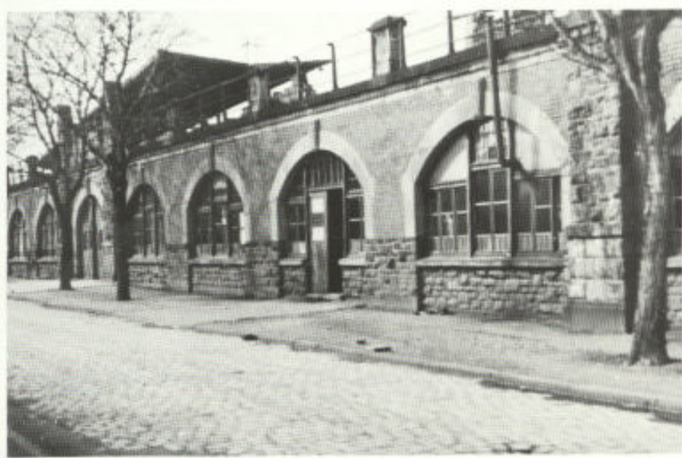
Abb. 5. Der Südbahnhof (Straßenseite) 1945
