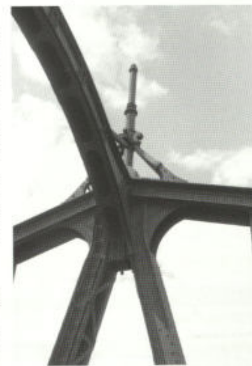
Abb. 10. Verbindung der verschiedenen Hauptträger
