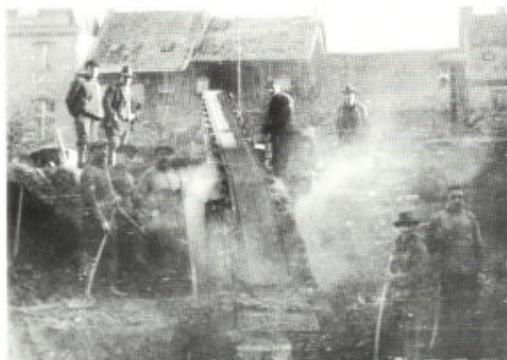
Abb. 12. Aushub für die öffentliche Bedürfnisanstalt und den Luftschutzraum
