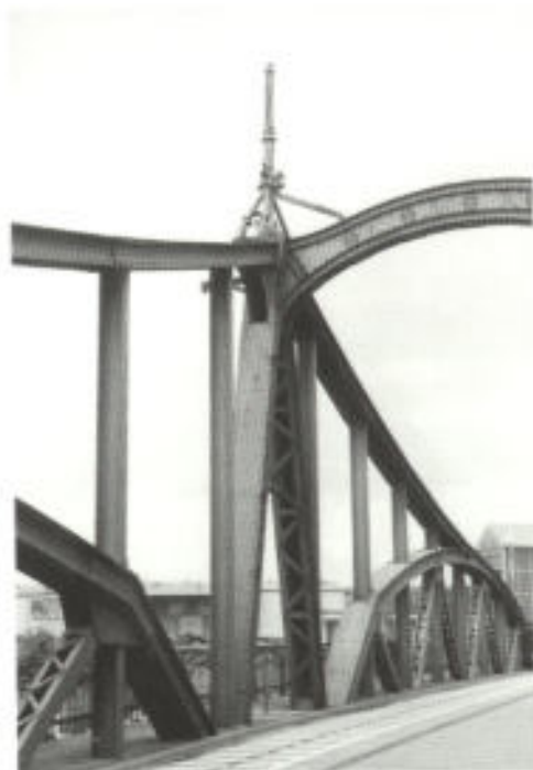
Abb. 9. Hängeseil mit Fachwerkträger
