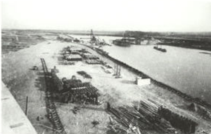
Abb. 3. Mittelpfeiler und Widerlager im Bau
