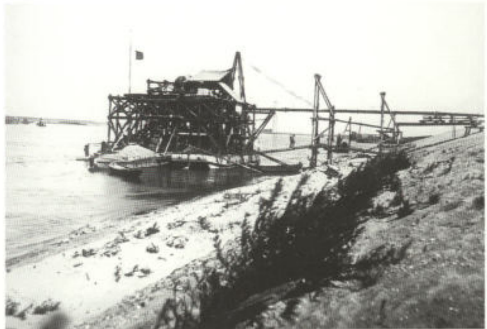
Abb. 11. Gerüst für den Bau eines Widerlagers
