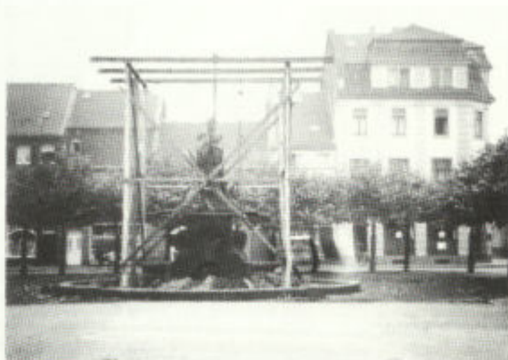
Abb. 10. Einrüstung des Kaiser-Friedrich-Brunnens
