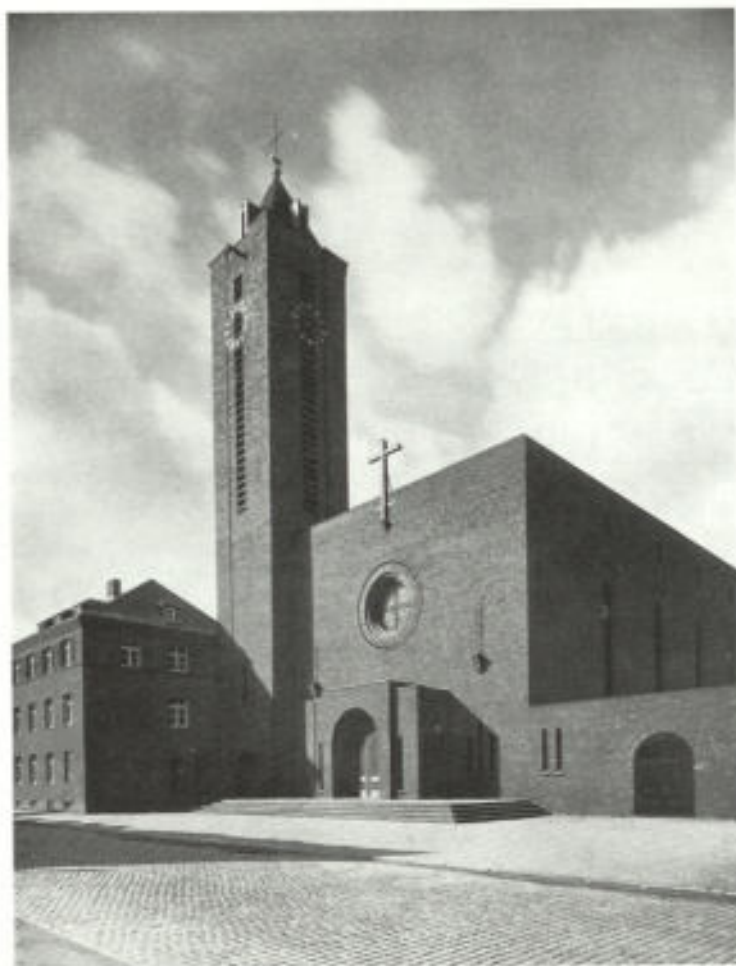
Abb. 2. Ursprüngliche Außenansicht der St.-Martins-Kirche, Krefeld
