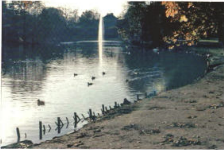
Abb. 12. Das Teichufer mit zerstörter Uferbefestigung und abgebrochenen Uferändern
