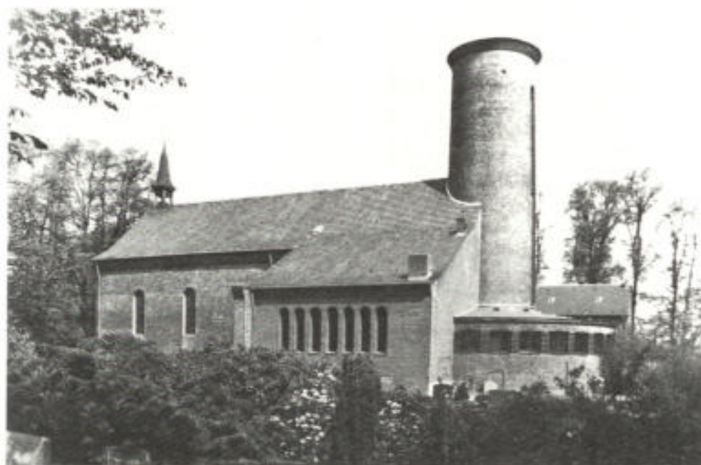
Abb. 1. Pfarrkirche St. Josef von Südosten
