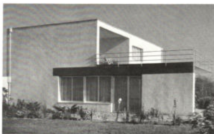
Abb. 3. Gesamtansicht von Westen. Terrassenbelag und Terrassenstirnseite in roten keramischen Platten ausgeführt, Betonunterzüge in stumpfem Grün.
