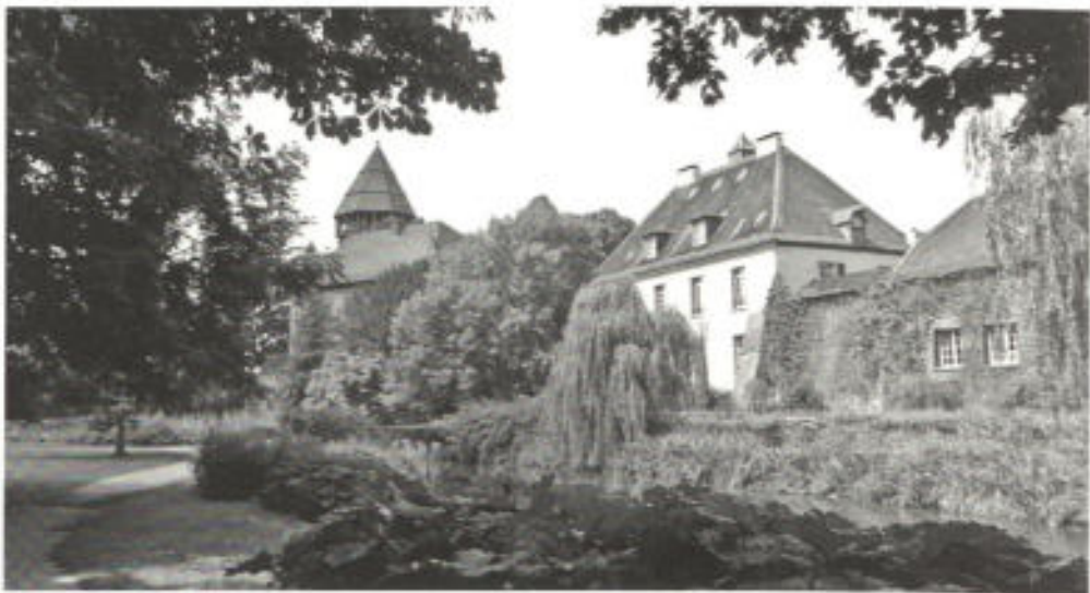
Abb. 4. Idylle im Sonnenschein – aber: Die Gebäude zeigen Risse. Durchs Dach des Jagdschlösschens dringt Regenwasser ein. Aus dem Bundes-Konjunktur-Topf soll Reparaturgeld fließen.
