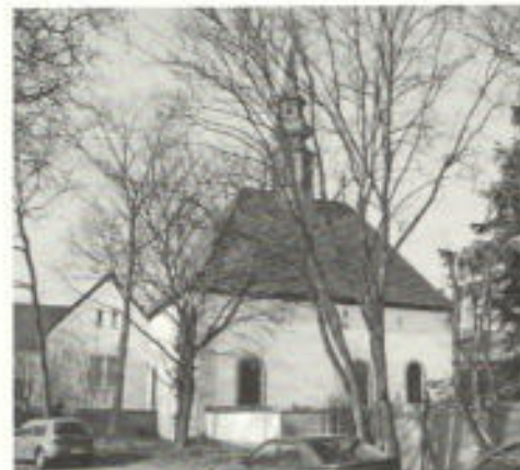
Abb. 59. Ev. Kirche Süchteln, erbaut 1669
