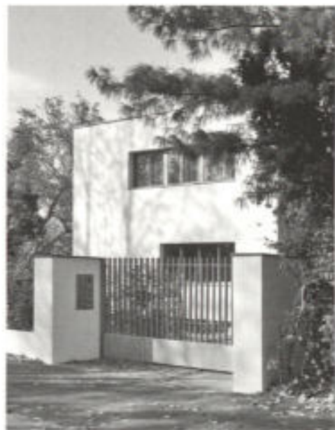
Abb. 4. Ostseite des Hauses nach der Instandsetzung
