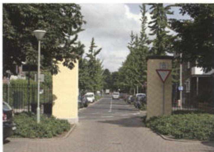
Abb. 11. Der sanierte Eingangsbereich
